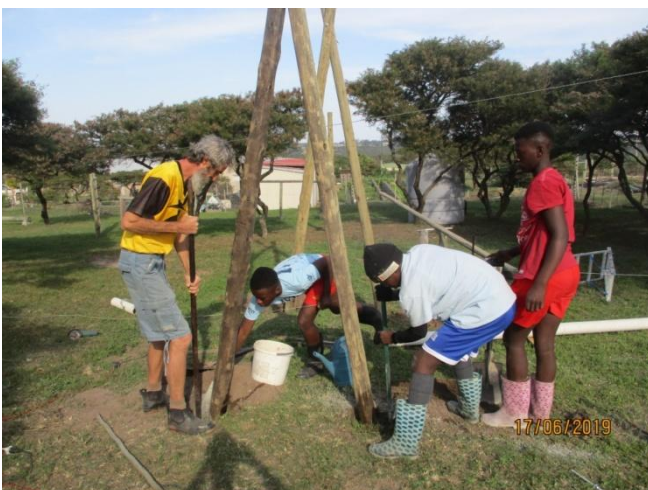
Het bouwen van een onderdeel van de hindernisbaan tijdens een schoolvakantie
